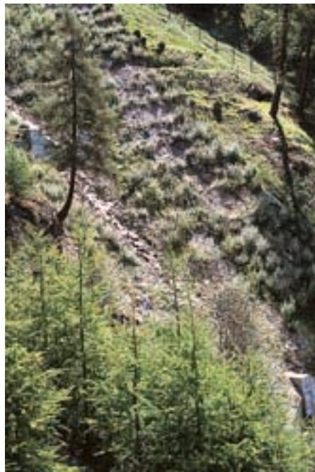
Fig. 5. Génie biologique et sylviculture: Stabilisation des berges d'un torrent dans la zone de la limite forestière. L'ouvrage est construit à l'aide d'un lit de plançons (boutures de saule) et d'une afforestation d'épicéas et de mélèzes (au premier plan).
