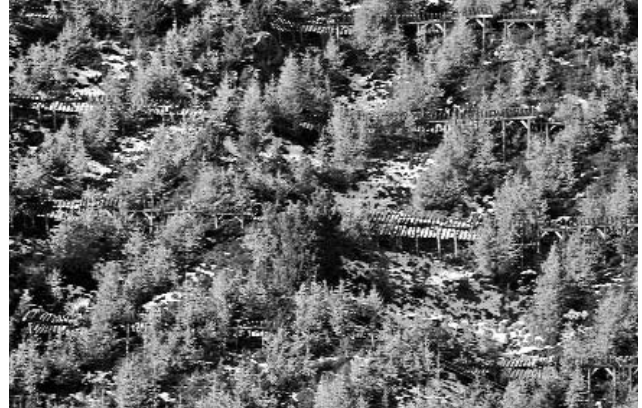
Abb. 3: Ausschnitt der Versuchsfläche Stillberg im Jahr 2008. Viele gepflanzte Bäume sind unterdessen höher als der temporäre Lawinerverbau und übernehmen bereits einen Teil der Schutzfunktion.
