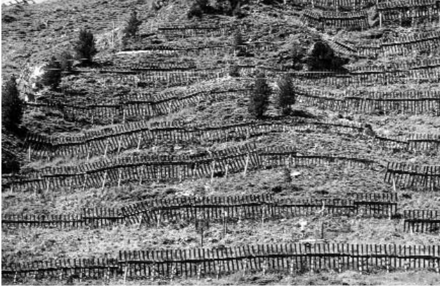
Abb. 2: Ausschnitt der Versuchsfläche Stillberg im Jahr 1982. Die 1975 gepflanzten Bäume sind zumeist noch kleiner als 50 cm. Deutlich zu sehen ist hingegen der temporäre Lawinerverbau, der im rechten Teil der Aufforstungsfläche errichtet wurde.
