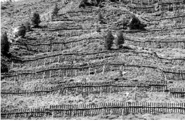
Abb. 2: Ausschnitt der Versuchsfläche Stillberg im Jahr 1982. Die 1975 gepflanzten Bäume sind zumeist noch kleiner als 50 cm. Deutlich zu sehen ist hingegen der temporäre Lawinerverbau, der im rechten Teil der Aufforstungsfläche errichtet wurde.
