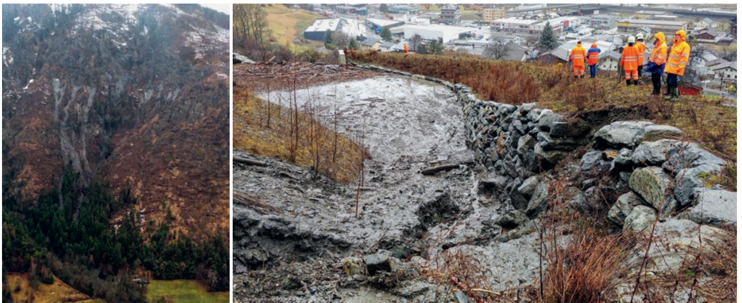
Abb 5 Murgang vom Januar 2018: Entstehungsgebiet (links); prall gefüllter Geschiebesammler (rechts). Im Hintergrund erkennbar ist die potenzielle Ablagerungszone im Wohn- und Industriegebiet Eyholtz, Visp. Fotos: Alban Brigger
