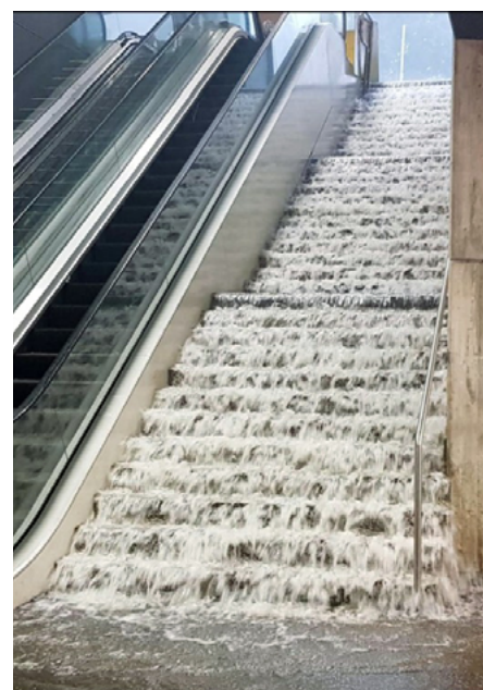
Bild 7: Eine mächtige Gewitterfront führte am 15. Juni im westlichen Mittelland von Genf über das Drei-Seen-Land bis in den Aargau zu Oberflächenabfluss und ausufernden Bächen. Im Bild der Bahnhof von Nyon VD (Foto: Leser-Reporter/ 20 Minuten).
