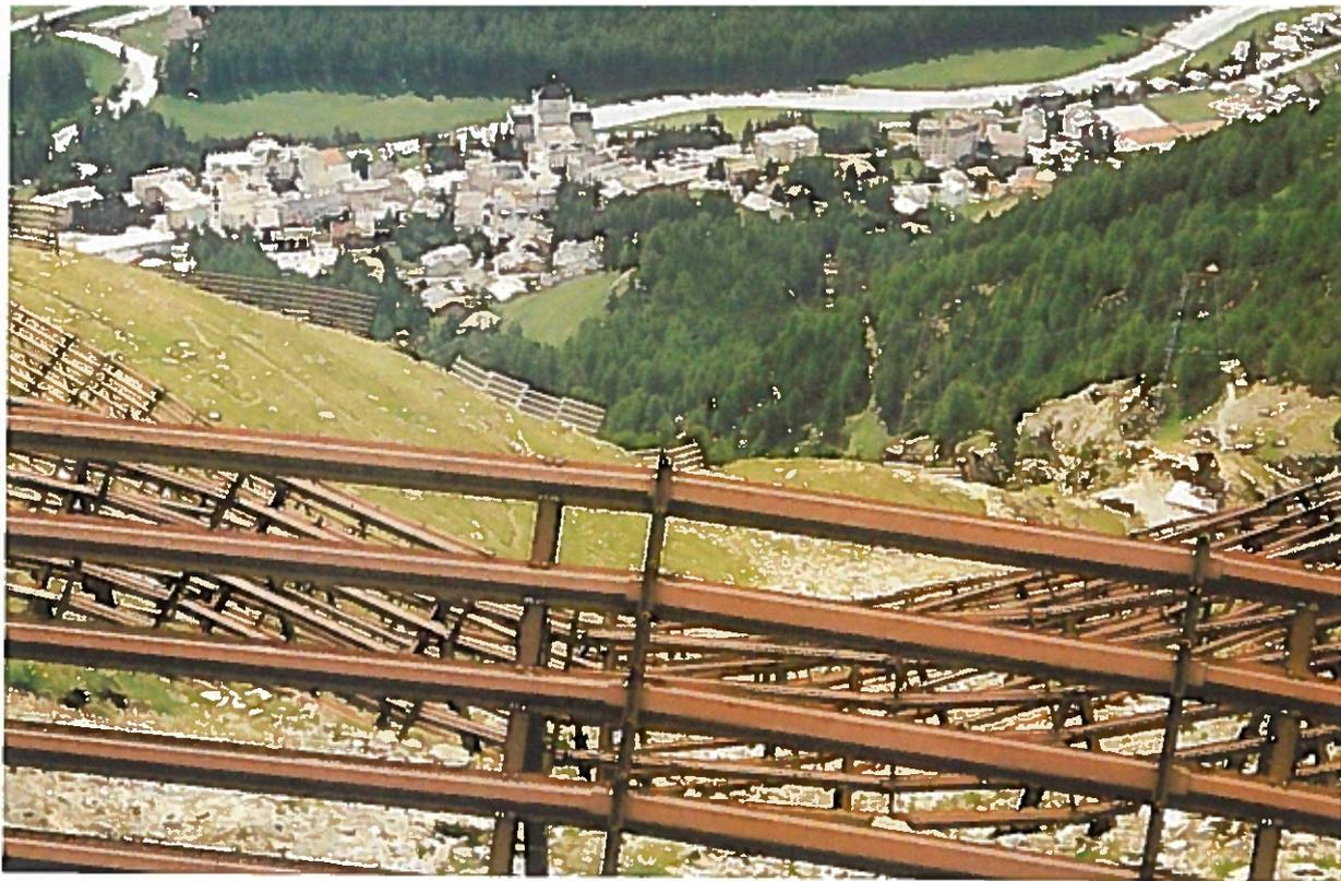
Eine der teuersten Lawinerverbauungen der Schweiz steht am Schafberg hoch über Pontresina. Vier Anker einer solchen Stahlschneebrücke könnten das Gewicht einer SBB-Lokomotive tragen.
