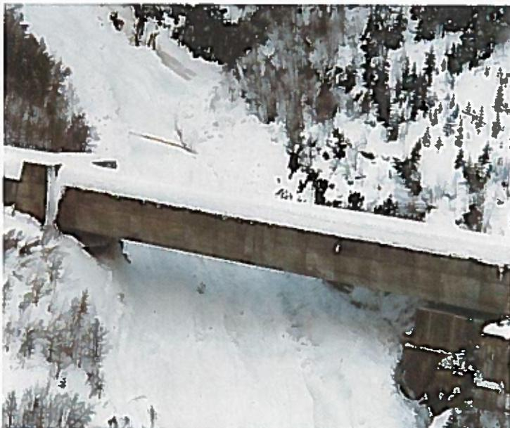
Zum Schutz des Eisenbahnverkehrs vor der Rorbach-Lawine ist diese Brücke auf der Gotthard-Strecke im Kanton Uri mit massivem Beton eingekleidet worden. Im Januar 1981 musste die wichtige Transitverbindung nach dem Niedergang noch gesperrt werden. Im Februar 1999 konnten die zu Tal donnernden Schneemassen hier aber keinen Schaden mehr anrichten.
