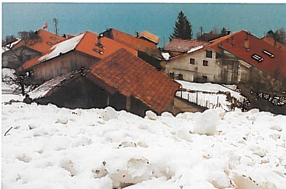
Auslaufgebiet einer Lawine aus dem Lauigraben bei Oberried (BE). Die Gebäude im betroffenen Siedlungsgebiet Dörfli liegen in der blauen Gefahrenzone, wo für Bauprojekte verstärkte Sicherheitsauflagen gelten. Das Wohnhaus rechts verfügt über eine bergseitig verstärkte Wand, die den Lawinenkräften standhält.
