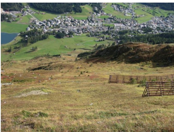
Abb. 7: Rutschanrisse sowie Lawinenverbauung (Davos).
