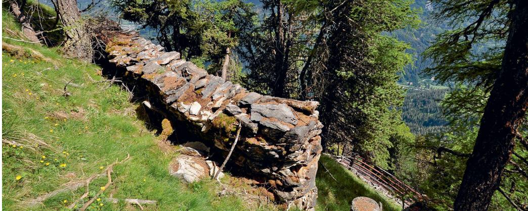
**Die erste technische Verbauung eines Lawinenanrissgebiets in der Schweiz unterhalb des Motta d'Alp hoch oberhalb von Martina. Im Vordergrund eine der 19 Steinmauern, die 1868 von Coaz projektiert wurde. Die frei stehenden Mauern befinden sich heute auch nach einer Nutzungsdauer von 150 Jahren in einem erstaunlich guten Zustand. 1987 wurden die Mauern mit Stahlschneebrücken ergänzt.** (Bild: Stefan Margreth)
