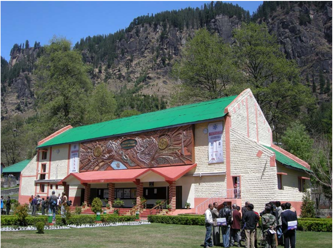
Abb. 1: Das SASE in Manali (hier eines der Gebäude auf dem Campus) ist das grösste Schnee- und Lawinenforschungszentrum der Welt (Foto: J. Schweizer).
