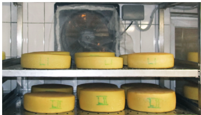
8.5 Radiateur avec ventilateur et filet anti-mouches dans le puits de lumière d'une fenêtre.
