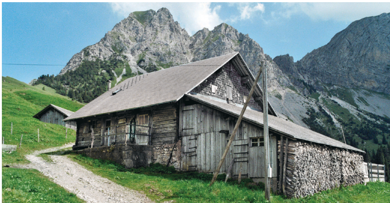
3.7 Chalet avec étable de vaches, construit selon la technique du blockbau (construction en madriers horizontaux) avec toit à fronton. Les bovins et les porcs sont logés dans la construction avec toit en appentis. Chalet Zurgilgen sur l'alpage Jänzimatt, Giswil OW.
