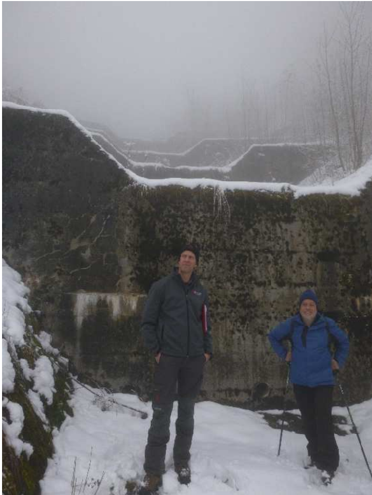
Foto 2: Sohlenstabilisierung mit Betonsperren im Ribibach im Bereich der Teilflächen B und C gemäss Diplomarbeit Schmidiger (Sepp Odermatt, Karl Grunder)
