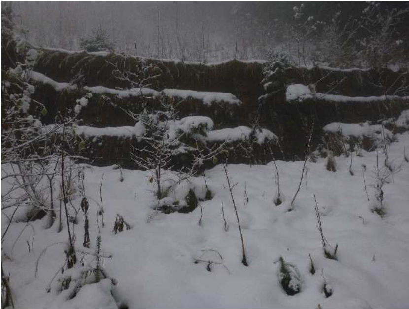
Foto 7: Drahtschotterkörbe als Stützbauwerke im Hang. Sie sind in die kompakte Moräne fundiert und gut entwässert.
