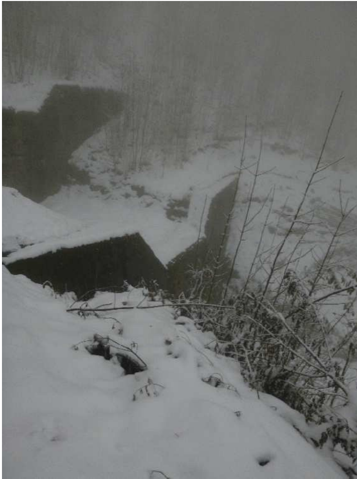
Foto 5: Blick auf den Gerinneverbau im Bereich der Ribí
