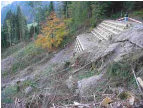
Abbildung 5.8: Mit Holzkasten verbaute Rutschungen an Strassenböschungen (Perimeter Entlebuch).
