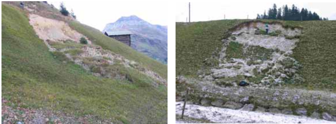
Abbildung 4.27: Rotationsrutschung (links) mit muschelförmigem Anriss sowie Translationsrutschung (rechts) mit hangparalleler Gleitfläche.
