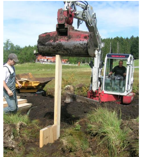
Auffüllen der Entwässerungsgräben in einem Hochmoor (Beck & Staubli).
