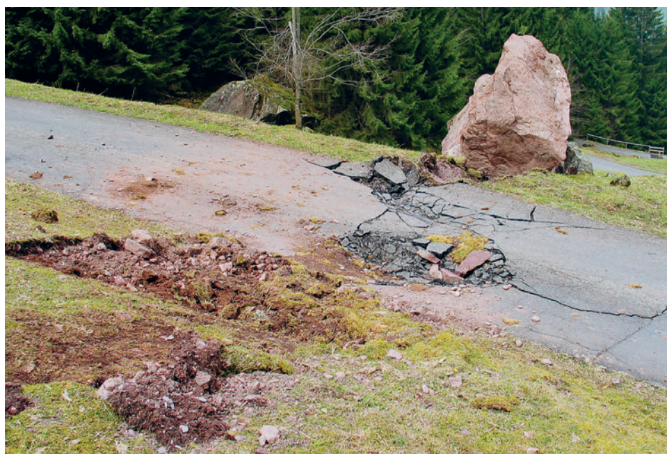
Murgtal, avril 2005. Un bloc de pierre dévale le versant de la montagne et s'écrase contre la Murgtalstrasse. L'équipe de développement de RAMMS utilisa cet événement pour tester le nouveau module de chutes de pierres.
