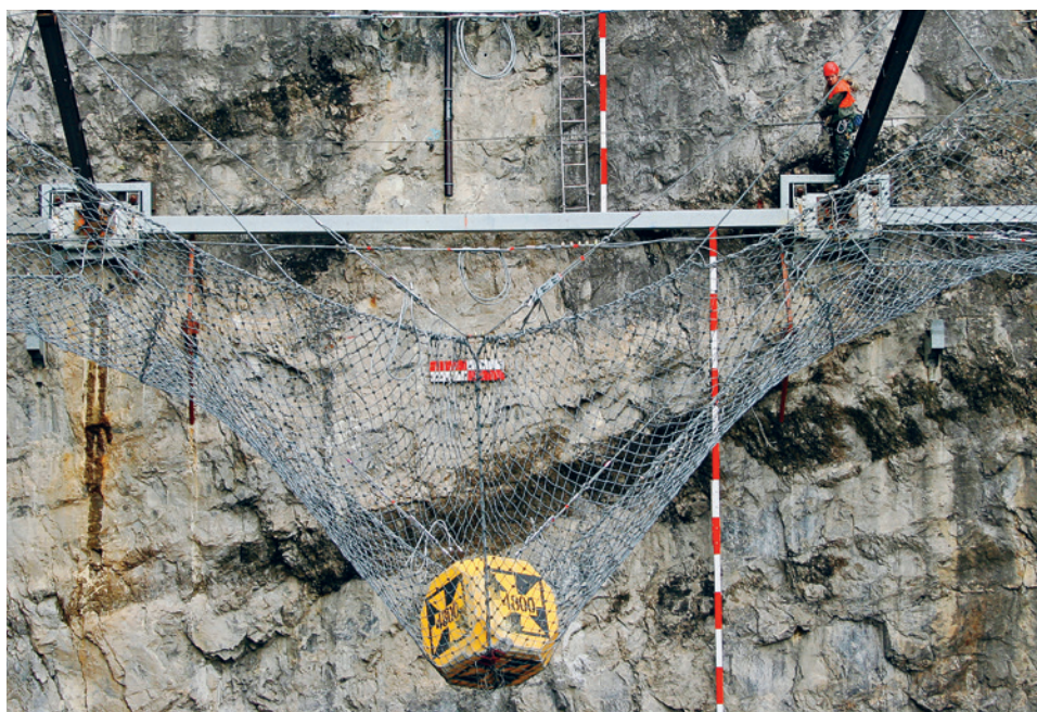
Dans l'installation-test de Lochezen près de Walenstadt, le WSL contrôle l'homologation de nouveaux filets de protection contre les chutes de pierres.
