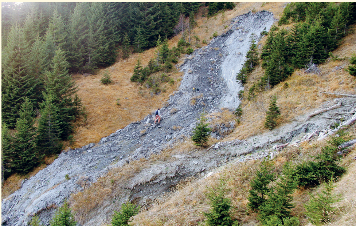
Dans de grandes clairières à l'image de celle située près de St. Antönien (GR), des glissements de terrain superficiels sont susceptibles de se déclencher.
