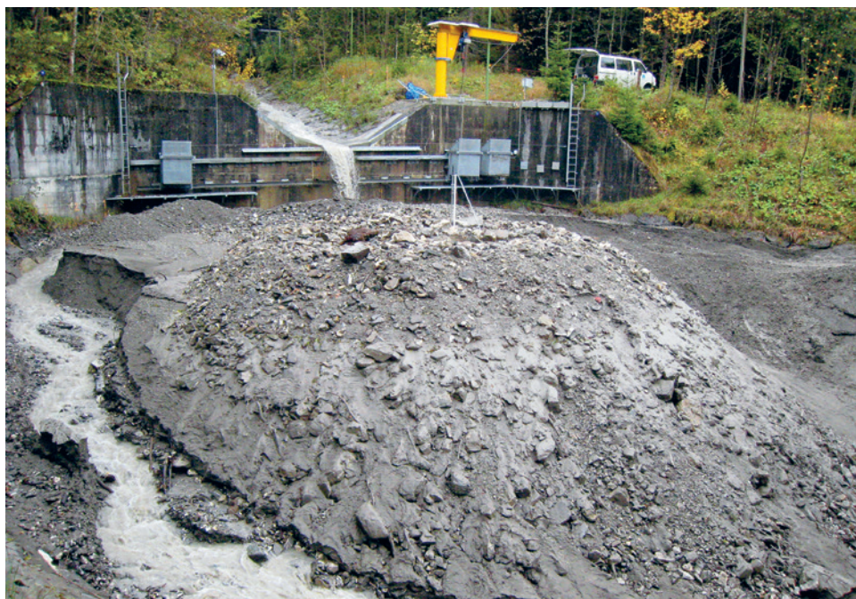
Les sédiments charriés par l'Erlenbach lors des crues s'accumulent dans le bassin de rétention. On procède régulièrement à leur mesure, puis à leur excavation.
