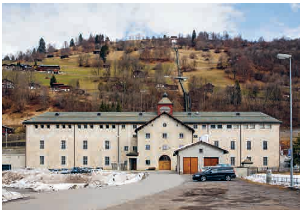
Das Kraftwerk Küblis liefert Strom für 35 000 Haushalte.
