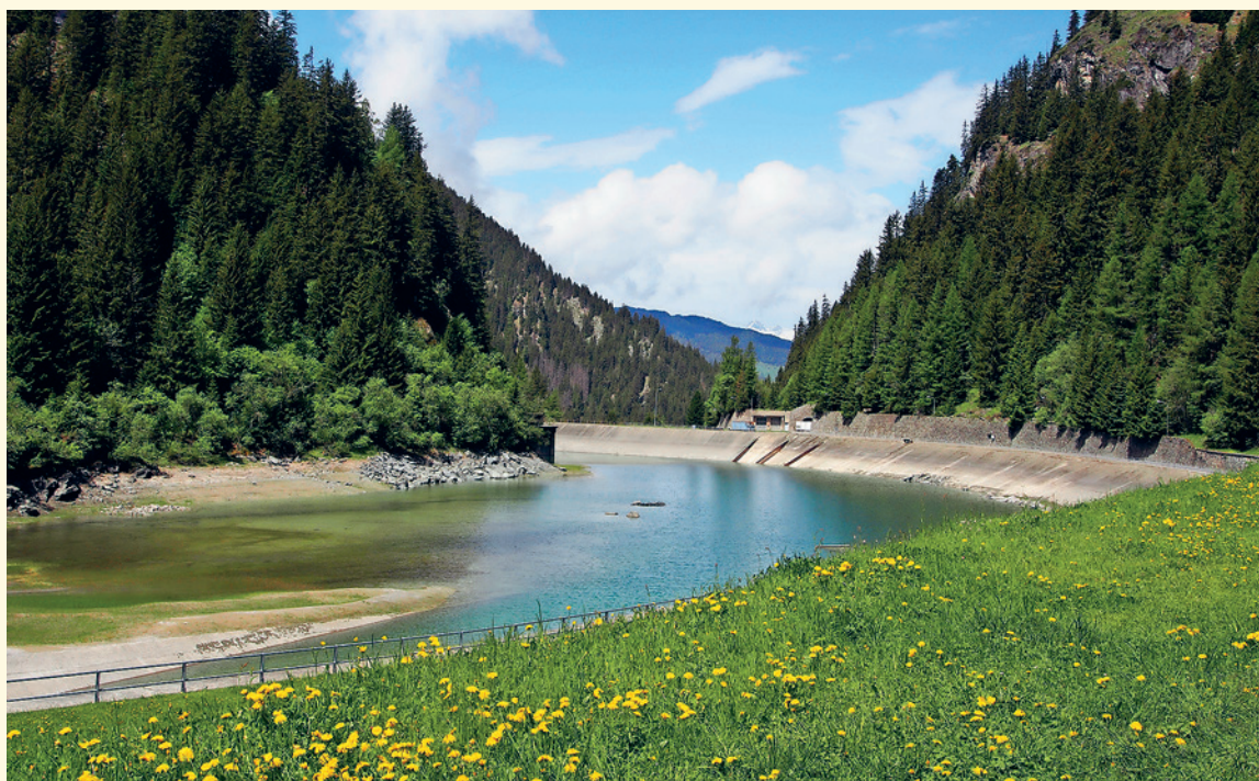
Das Wasser in künstlichen Speicherseen, hier im Val de Bagnes (VS), ist vorwiegend für die Stromproduktion reserviert.
