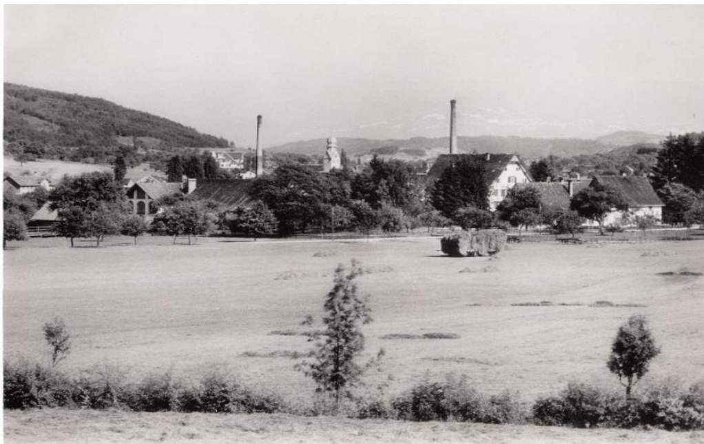
Abb. 47 Tänikon im Jahr 1905 (im Hintergrund die Schornsteine der Tonwarenfabrik)
