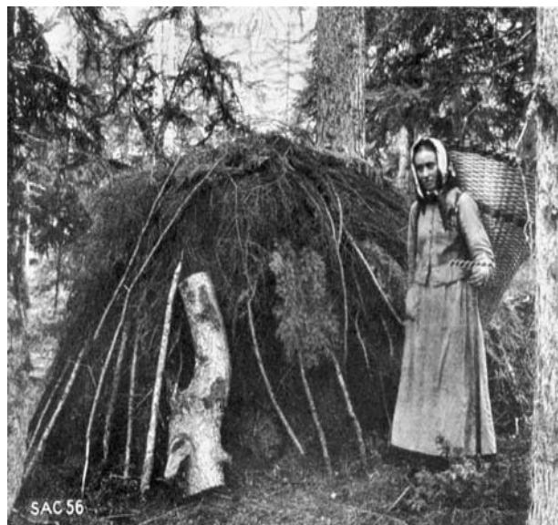
Abbildung 12 | Waldstreuehaufen mit Deckholzschicht, VS
