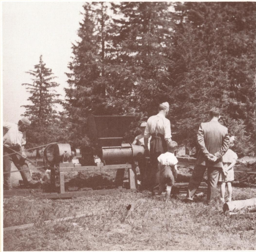
Herstellung von Maschinentorf für Heizzwecke im Jahre 1942 durch die Torfstreifefabrik Oberriet im Hochmoor Gamperfin.
