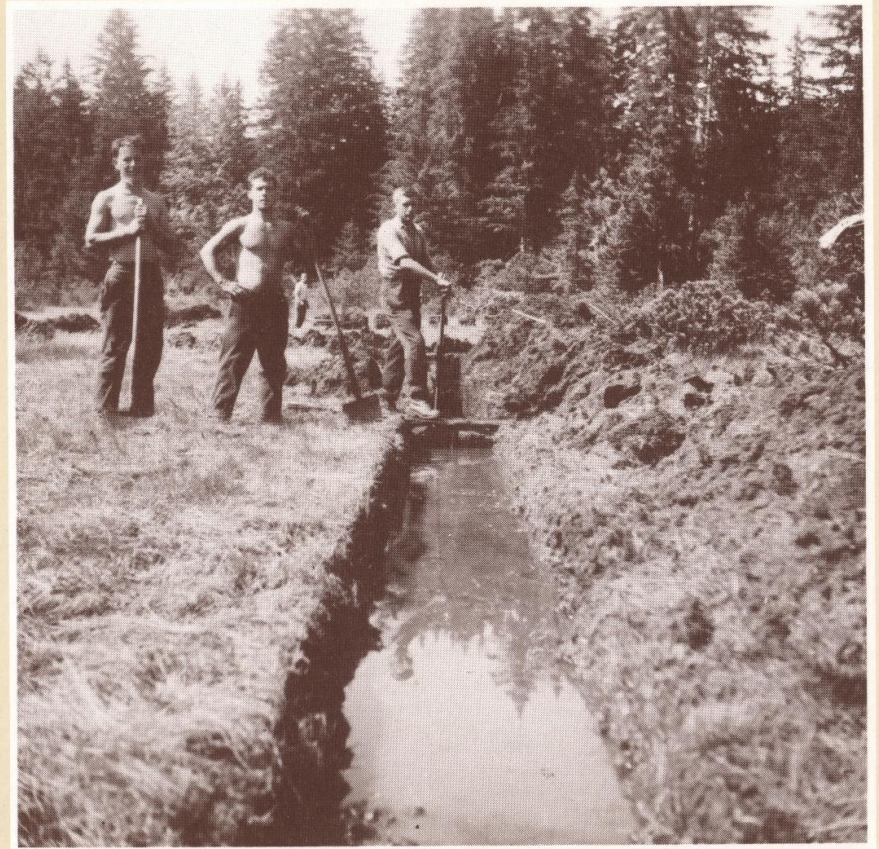
Oftmals musste zur Erschliessung neuer Abbaugebiete zuerst entwässert werden – Entwässerungsgraben auf Gamperfin.
