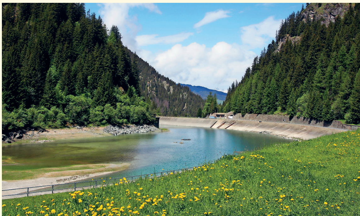
L'eau des bassins artificiels d'accumulation, ici au Val de Bagnes (VS), est principalement destinée à la production d'électricité.
