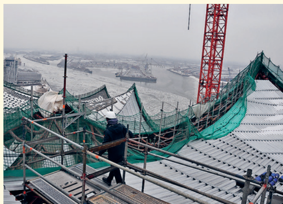
Le toit de la Philharmonie de l'Elbe a une inclinaison pouvant atteindre 50°. Grâce au choix judicieux des matériaux, il est possible d'empêcher des avalanches de toit.
