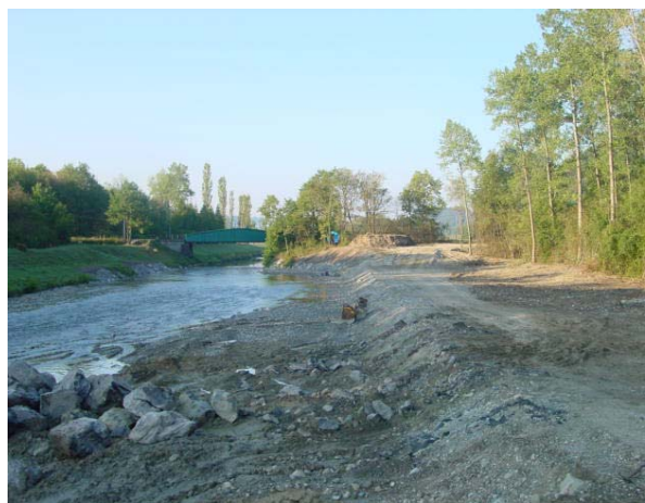
Septembre 2003, zone déversoir
