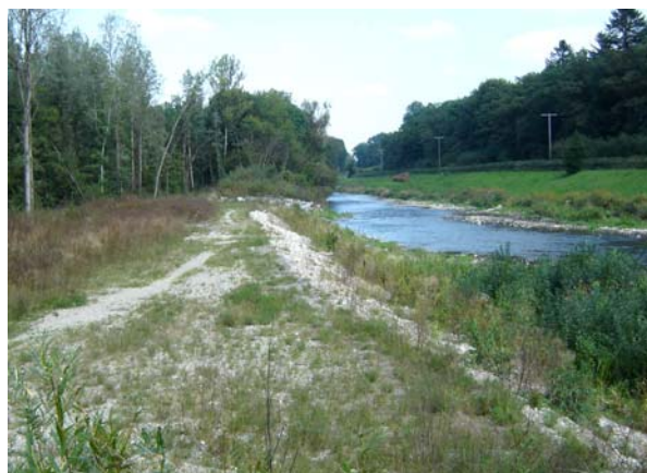
Septembre 2005, zone déversoir
