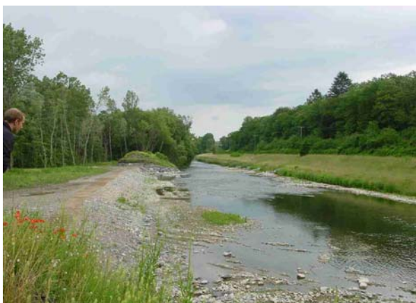
Juin 2004, zone déversoir
