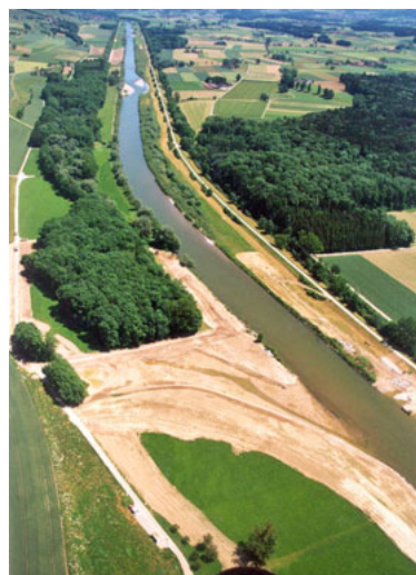
Figure 2.4 : La Thur canalisée à Schafftäli, TG/ZH, en juin 2001. (Photo : C. Hermann, BHAtteam, Frauenfeld)
