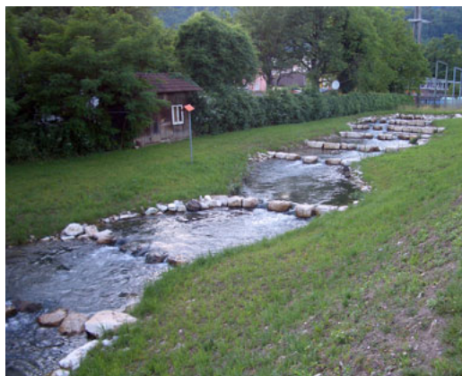
Figure 7.25 : Rivière de contournement de l'Aar à Winznau, SO, 2005 (Photo : A. Peter, Eawag, 2004).
