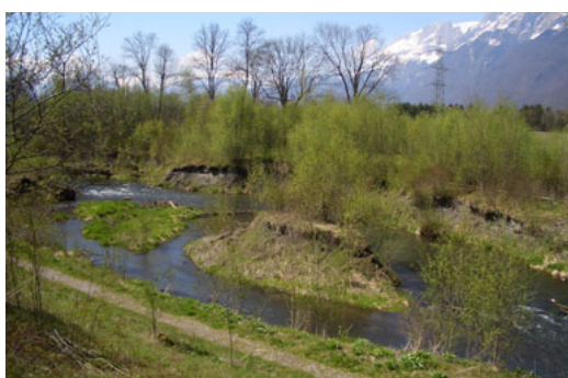
Figure 7.4 : Elargissement de la rivière Pascoletto près de Grono, GR, 2002 (Photo : M. Hostmann, Eawag).
