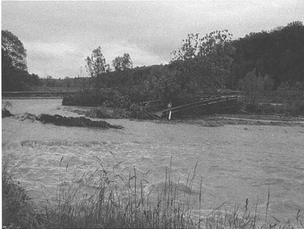
Hochwasser Mai 1999, Abschnitt MR2 (Bild: T. Gebert)
