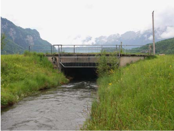
Abb. 34: Der Aarekanal vor der Verrohrung unter dem Militärflugplatz (2010)
