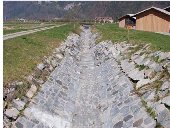
Abb. 27: Die Gewässersohle ohne Benetzung von Wasser (2010)
