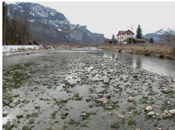
Abb. 11: Die Kiesbankstrecke bei Meiringen (2010)
