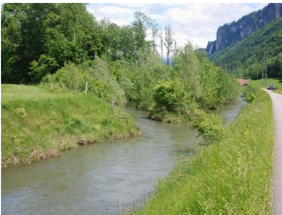
Abb. 36: Die Aufweitungen des Aarekanals (2010)
