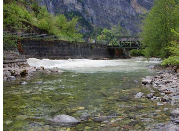
Abb. 21: Die Wasserrückgabestelle des turbinierten Wassers (2010)
